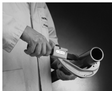
Отрезание трубы необходимой длины
